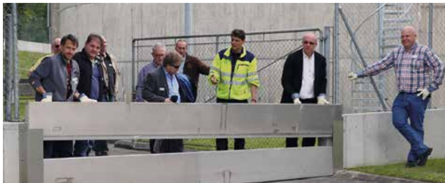
Pose d'un barrage à l'entrée de la STEP de Roche par chaque groupe
